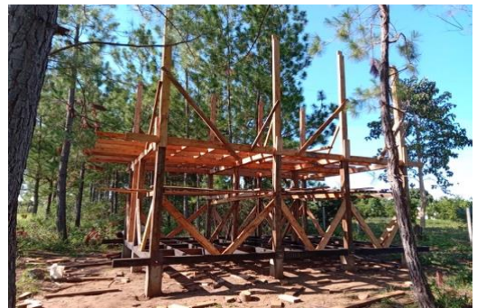
trainingsgebouw in aanbouw
