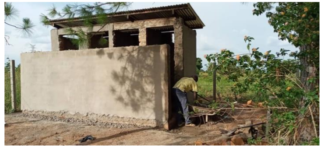
bouw van de sanitaire ruimte
